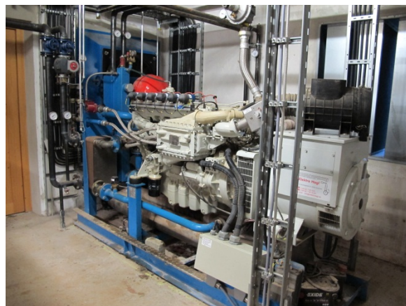
Фигура 29: КТЕ: биогаз за електричество и топлинна енергия. снимка: Ф. Йенш, RENAC.
