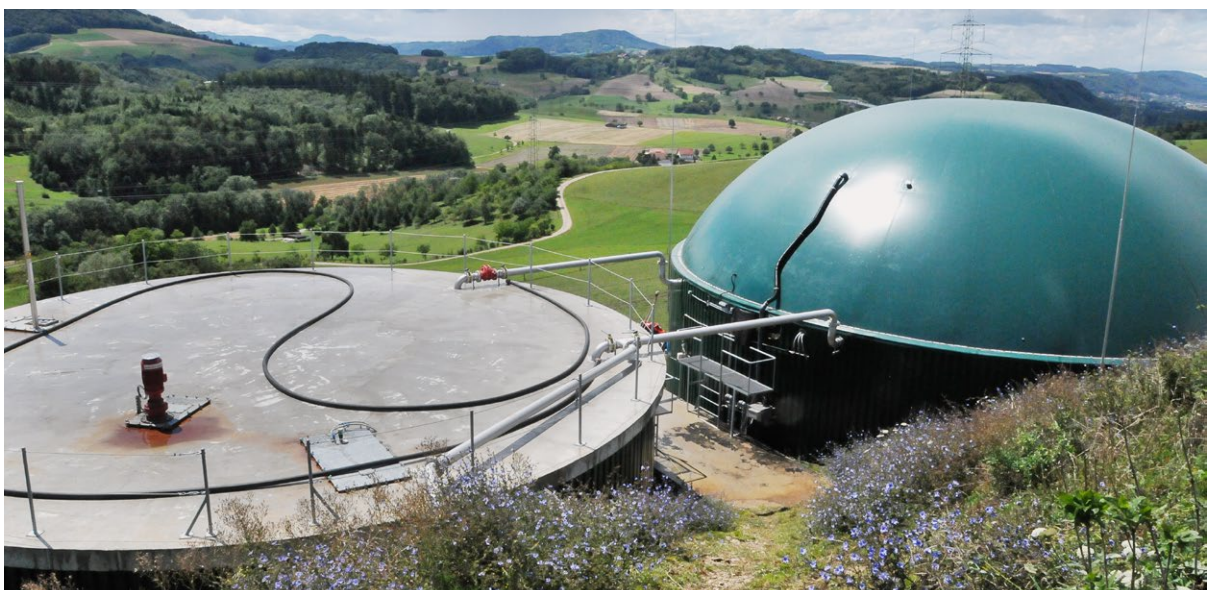
Landwirtschaftliche Co-Vergärungsanlage für die Erzeugung von Energie aus Hofdüngern und Co-Substraten (weniger als 20%).
